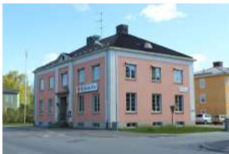
Kyrkans hus vid Storgatan 28 i Fjugesta byggdes som ett 1920-talsklassicistiskt bankhus och har vissa likheter med ett bankhus i Kumla.
