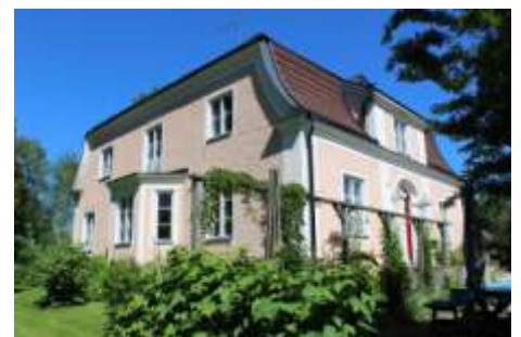
Denna villa på Möbelvägen 10 i Gropen byggdes av en fabrikör som senare gick i konkurs och aldrig inredde övervåningen.
