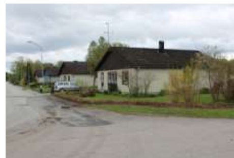
Längs Egnahemsgatan i Fjugesta finns hus som tycks vara byggda av stående element av lättbetong.
