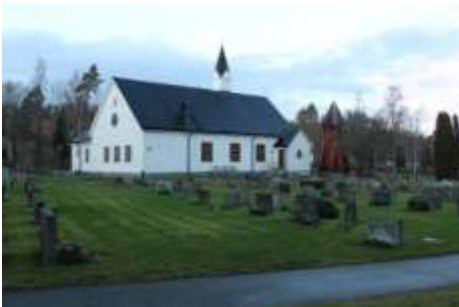
Mullhyttans kyrka är Lekebergs yngsta tidigare statskyrka som byggdes under 1920-talet då Mullhyttans tycks ha expanderat.
