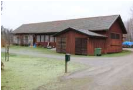
Vid Hemsjöstrand Sörbytorp 298 A finns denna byggnad som har fungerat som snickeri och troligen också som mekanisk verkstad.
