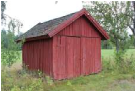
Denna bod norr om Norra Övratorp är byggd med olika breda brädor som ger byggnaden ett livfullt intryck trots sitt enkla yttre.
