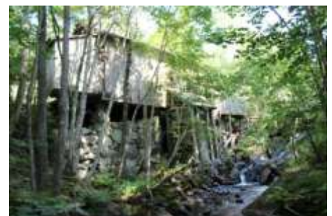
Sågen vid Vekhyttan Strömsnäs 1 drevs av Lillåns vatten och står på en sockel av granit men stöds även av trästolpar.
