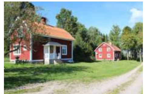
Vid Riseberga gård finns flera arbetarbostäder med brutet tak i 1920-talsstil. Det borte huset är något större och kan vara förmansbostad.
