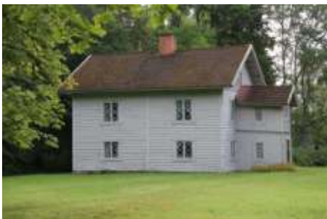
Fallet Nytorp kan vara en arbetarbostad under Trystorp och har ovanliga fönsterbågar med kryssande spröjsar.
