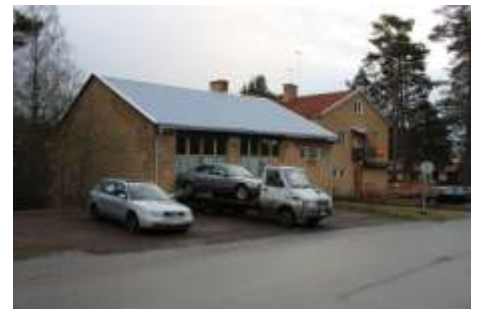
Tryggebodavägen 2 i Mullhyttan byggdes på 1950-talet och innehöll brandstation, lägenhetshus, samlings- och affärslokaler
