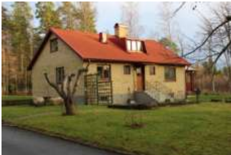
Det gula fasadteglet och de spröjslösa fönstren gör Tryggebodavägen 20 i Mullhyttan till en tydlig villa från tiden kring 1900-talets mitt.
