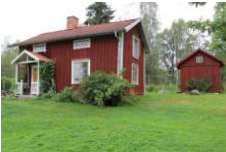
Den lilla enkelstugan vid Vekhyttan Lindfallet 3304 har krysspröjs i de övre fönstren på långsidorna.
