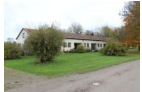
Göksvalla Nybo är det närmaste en statarlänga man kommer i våra trakter och här bodde troligen lantarbetarna rätt modernt på sin tid.
