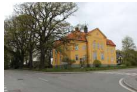
Tingshuset på Vallgatan 15 i Fjugesta från 1913 ger ett mäktigt intryck som förstärks av ekarna längs Fjugesta Letstig.
