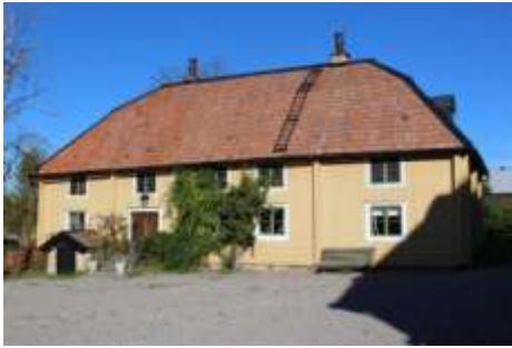
Den norra flygeln vid Bärsta gård har trekupigt taktegel och järnskorstenar medan det brutna taket påminner om 1700-talet.
