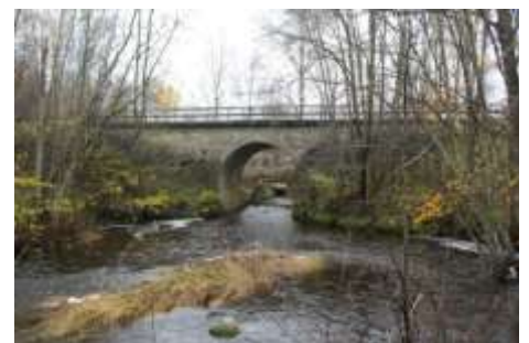
På 1860-talet byggdes en imponerande valvbro av huggen sten vid dåvarande Karlskogavägen vid Skärmartorp.
