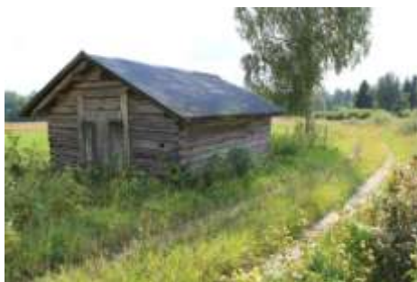
Denna ängslada söder Vekhyttan Kullen har fått ett plåttak för att kunna leva vidare, vilket är en enkel men mycket effektiv åtgärd.
