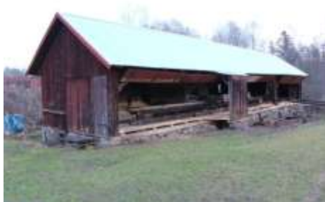
Mullhyttans ramsåg ligger nära Mullån och bör ha drivits av vattnets kraft men hålls numera igång med en förbränningsmotor.
