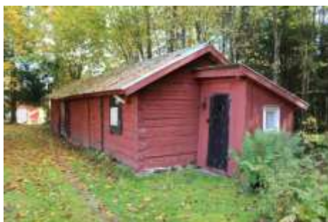
Uthuset vid Södra Folkavi 5238 är en låg, timrad byggnad med tillhörande dass vid ena gaveln.
