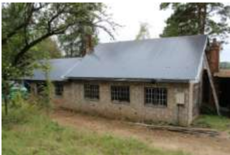
Längs vägen vid Edsbergs Sörby finns denna verkstadsbyggnad i betongsten som kan vara byggd omkring mitten av 1900-talet.
