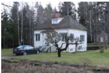
Stationsvägen 8 i Mullhyttan präglas av funktionalismen med spröjslösa fönster nära hörnen som tidigare varit tekniskt svårt att få till.
