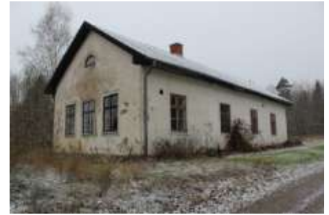
Lekhyttans gamla skola ger ett bastant men stramt intryck med sin putsade fasad och massiva väggar.
