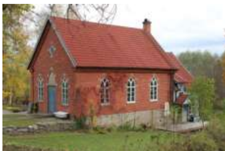
Lanna metodistkapell bör ha byggts vid sekel-skiftet 1800-1900 och är uppfört i tegel med nygotsikt spetsiga fönster.
