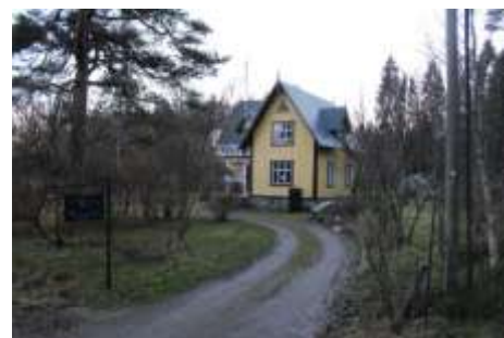
Det branta taket, de sågformade vindskivorna och spetsarna i gavelspetsarna utmärker villan på Stationsvägen 14 i Mullhyttan.
