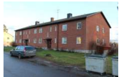
Lägenhetshuset vid Furuvägen 8 i Mullhyttan har mörkare fasadtegel och spröjslösa fönster med sidoluft, och bör vara från 1960-talet.
