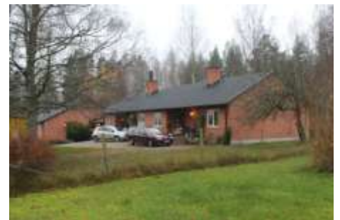
Pensionärsbostäderna var de första hyreshusen i Lekeberg. Skärmartorp 19 är ett av få sådana hus på landsbygden.
