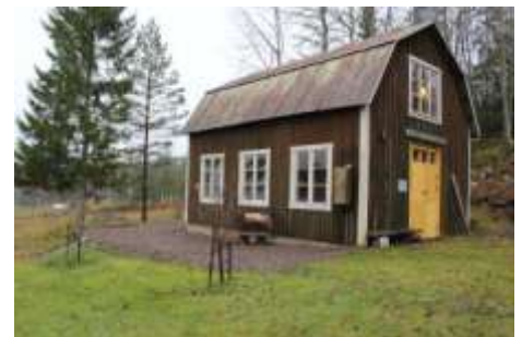
Forsbergs slöjdfabrik vid Ribbohyttan 3231 var en liten träindustri där huset har kvar sin ursprungliga prägel.
