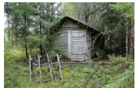
Denna mycket enkla koja vid Fredrikslund i södra Tångeråsa är byggd av klena granstammar men har å andra sidan en rejäl spegeldörr.
