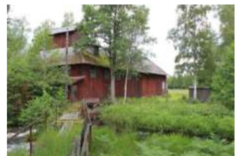
Vid Slästorp ligger Lekebergs mest kompletta, äldre torvströfabrik. Den drevs av vattenkraft och uppges bara ha fungerat så länge vattnet i dammen stod tillräckligt högt.
