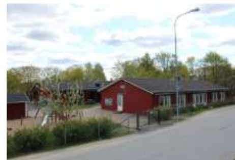
Tummelitens förskola på Östra Långgatan 26-28 i Fjugesta är nuvarande Lekebergs kommuns äldsta ursprungliga förskolebyggnad.
