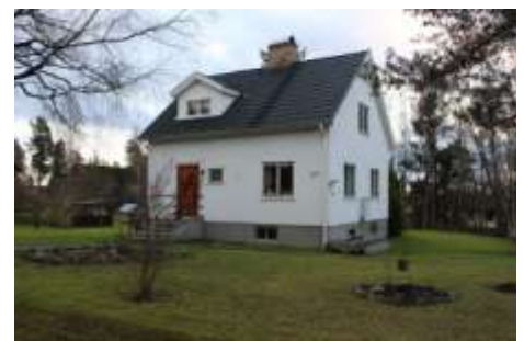
Bergbacken 13 i Mullhyttan är en slätputsad villa från mitten av 1900-talet med spröjslösa fönster, källarvåning och betongtrappa.
