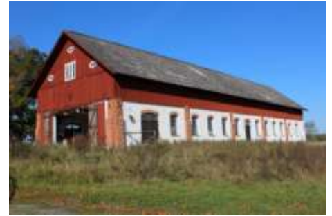
Ladugården vid Övre Gysta bör ha byggts i början av 1900-tal och den livfulla fasaden utgörs av både vit puts, tegel och rödmålat trä.
