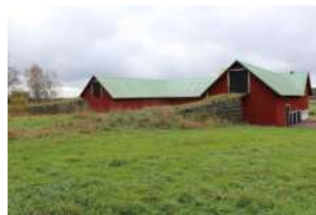
Ramperna och körbanorna till denna ladugård vid Västra Göksvalla gjorde det möjligt att köra hela in hölass i huset.
