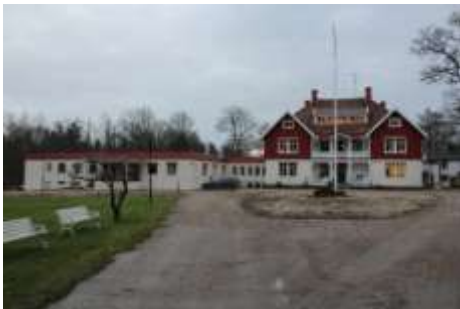
Brotorp Bergsmansgården byggdes i början av 1900-talet och fungerar idag som behandlingshem med utbyggnader i olika epoker.
