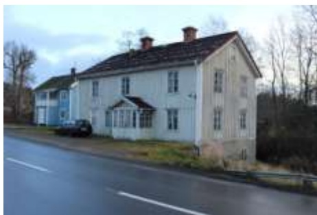
Mullhytte letstig 33 är byggt i en mer traditionell form med stomme av liggande timmer och har inrymt en affärslokal.
