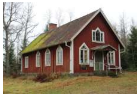
Hälsingsåsens missionshus liknar flera andra frikyrkor i Lekebergslagen med spetsiga fönsteravslut och tre fönster i entréns gavel.
