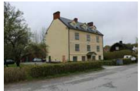
Lägenhetshuset vid Hagagatan 11 i Fjugesta ser ut som en rest av ett i övrigt rivet stads- kvarter, men det har alltid stått ensamt.
