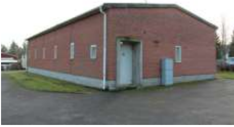
På telefonstationen på Selhagsvägen 4 i Mullhyttan finns ännu särskilda knoppar för att koppla in fälttelefoner i händelse av krig.
